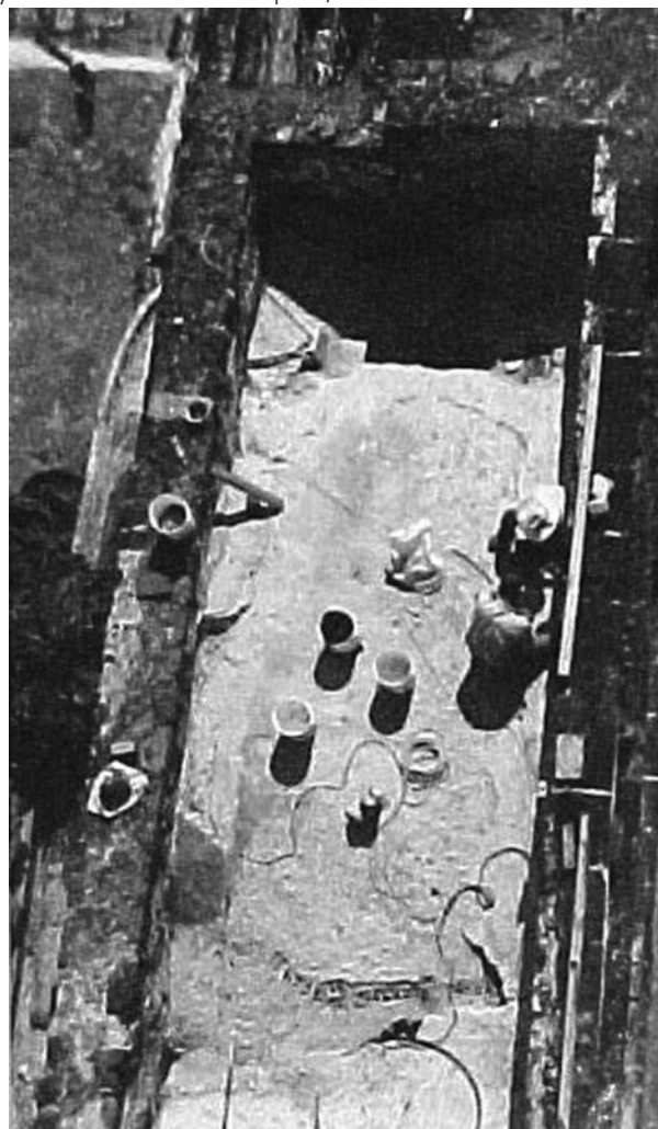
Consolidación de bóvedas en Tochimilco, México. Foto: Centro inah Puebla.
