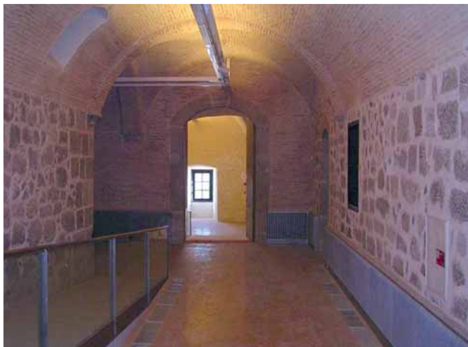
2. Deambulatorio de la planta semisótano de la nueva sede del Museo después de la rehabilitación arquitectónica. © Museo del Ejército.
