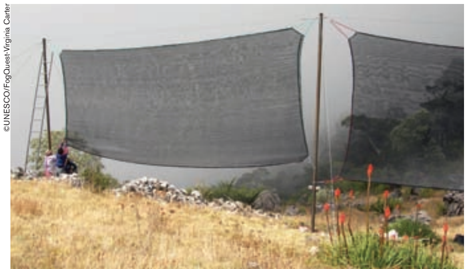
La construcción de redes de niebla en La Ventana, Guatemala.
