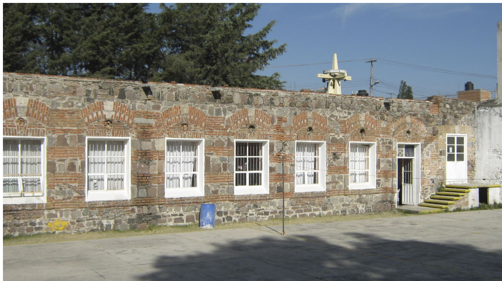
Figura 5. Edificio de la actual primaria Raúl Isidro Burgos. Imagen: ©Guillermo Aguado, 2015.
