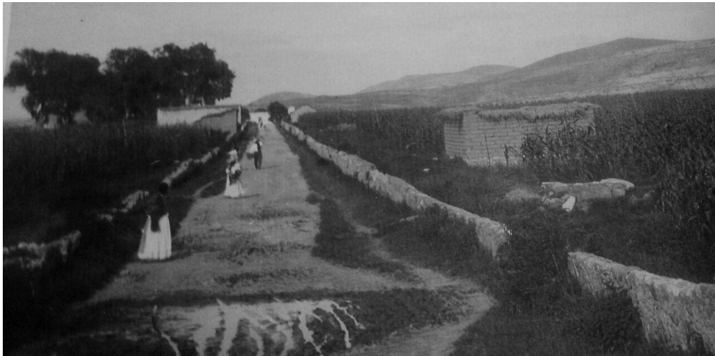
Figura 7. En esta fotografía de 1920 ca. se observa un camino sembrado de maíz a ambos lados. Imagen: ©Araceli Rodríguez, 2014.
