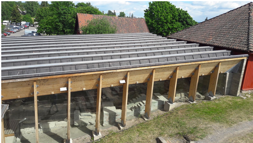
Figura 15: Fotografía de la cubierta del proyecto de ampliación del Museo Hedmark de Sverre Fehn construido en el año 2005. Imagen: © Iñigo Peñalba, 2016.
