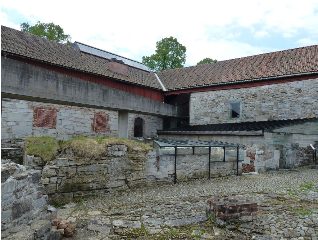
Figura 13. Fotografía de uno de los restos de muro restaurados donde se aprecia la superficie vegetal en la coronación del muro para su protección frente al agua de lluvia. Imagen: ©Iñigo Peñalba, 2016.
