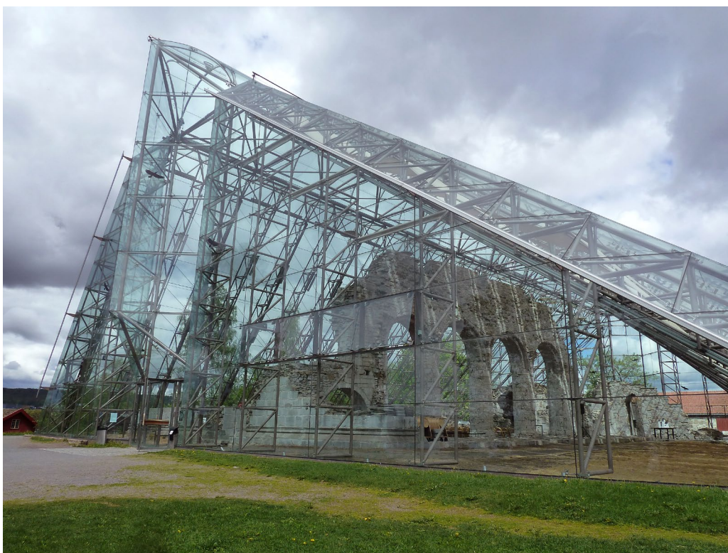
Figura 16. Fotografía de la estructura protectora de vidrio de la antigua Catedral de Hedmark en Hamar. Proyecto de Lens Otto y Lung. Imagen: ©Iñigo Peñalba, 2016.
