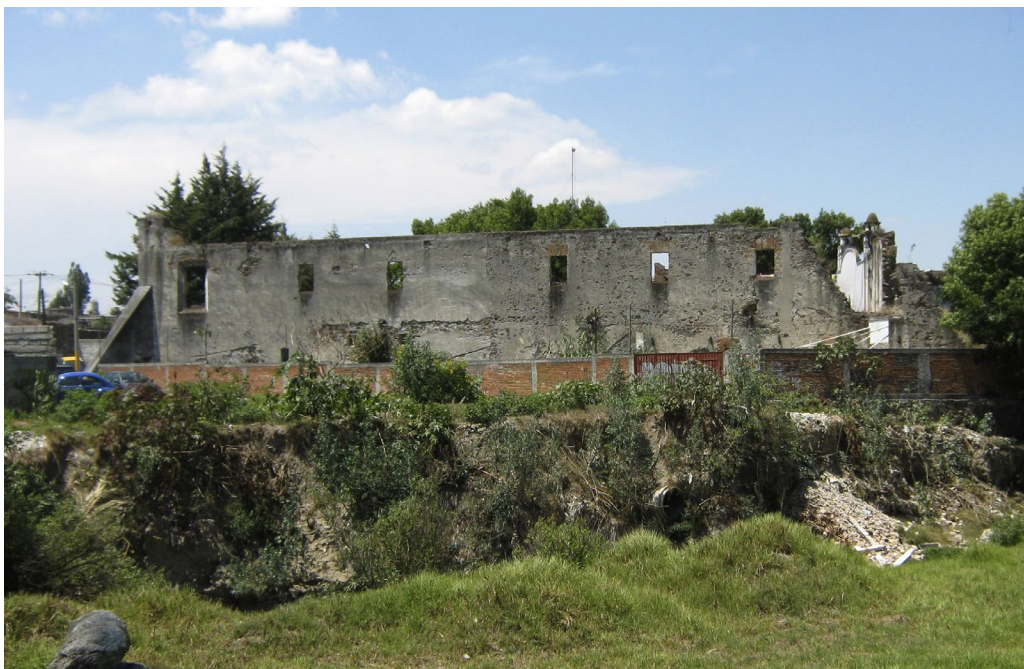
Figura 11. Vista del inmueble sur desde la ribera oriental del río Alseseca, antes de la construcción de un edificio escolar anexo. Imagen: ©Guillermo Aguado, 2015.
