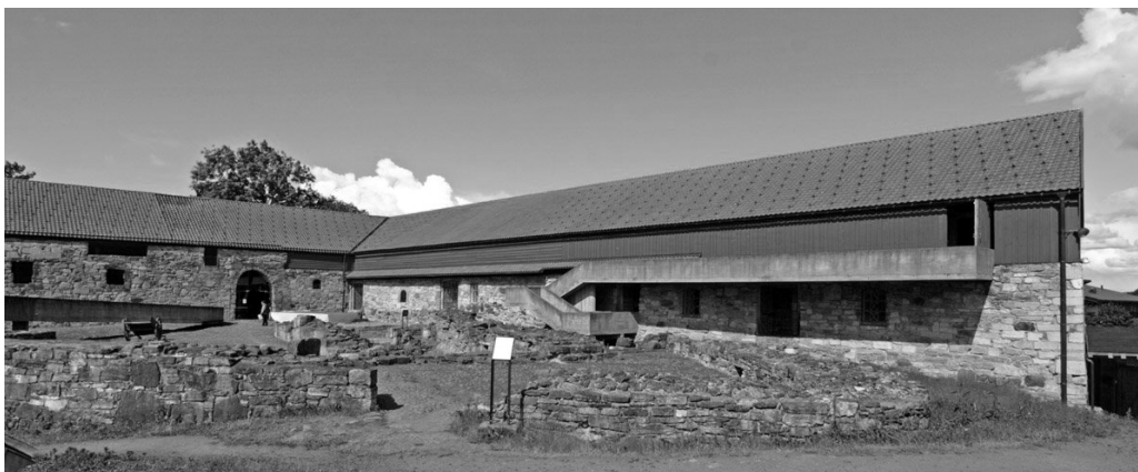
Figura 10. Vista del Museo Hedmark donde se aprecia la tejavana situada encima del muro de piedra. Sigue la línea horizontal del vuelo de hormigón hacia el patio. Imagen: ©Nasjonalmuseet Arkitektur Fotoarkive, 1984.
