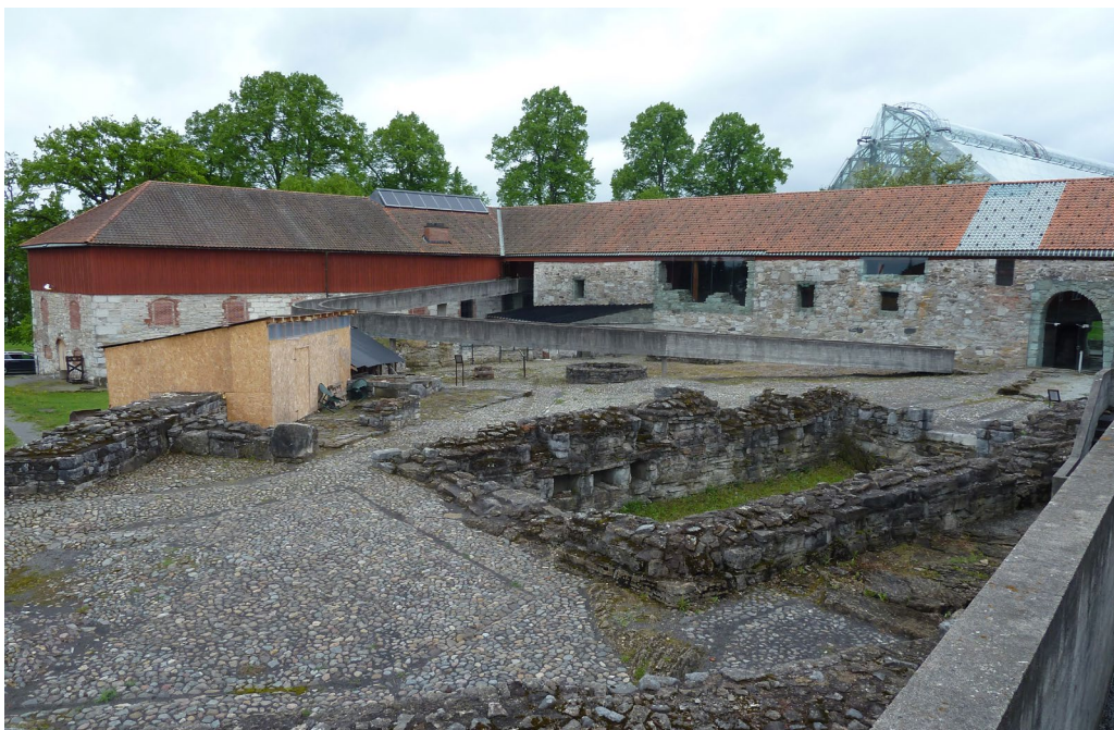
Figura 12. Patio del Museo Hedmark, se observa el estado de las ruinas de la fortaleza del obispo y las casetas protectoras donde se llevan a cabo los trabajos de restauración. Asimismo, se aprecia el color oscuro de la teja por la proliferación de algas, sobre todo en la orientación norte. Imagen: ©Iñigo Peñalba, 2016.
