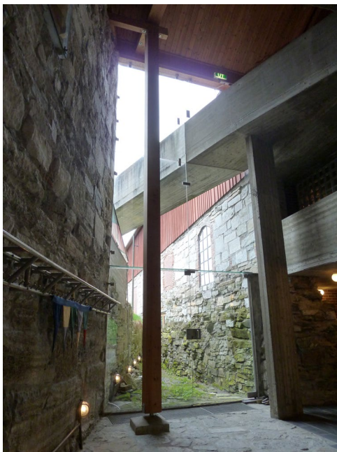
Figura 5. Fotografía de las planchas de vidrio en su encuentro con los muros existentes y la rampa de hormigón armado, que atraviesa el vacío del paño vertical. Imagen: ©Iñigo Peñalba, 2016.
