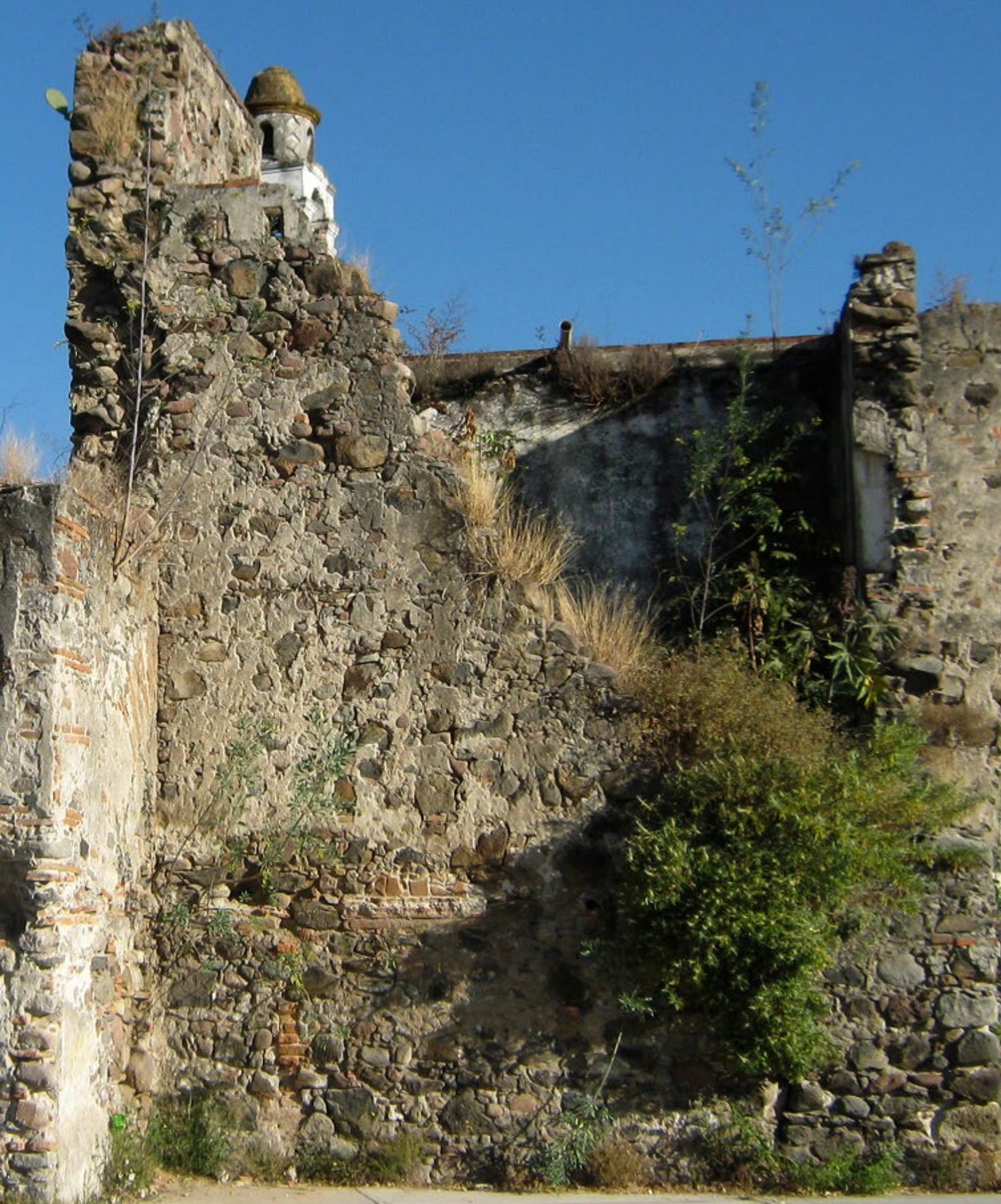
Muro sur de la ex hacienda de El Cristo en Puebla.
