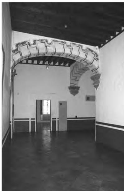
Fig. 8. Claustro alto con cubiertos de viguería.
