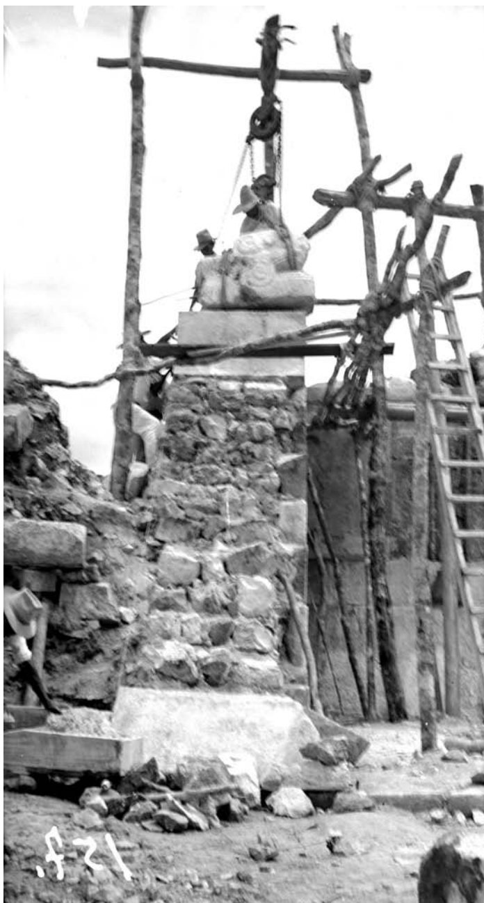
Trabajos de reconstrucción de la plataforma de Venus. Inv. 302973, Sinafo-INAH.
