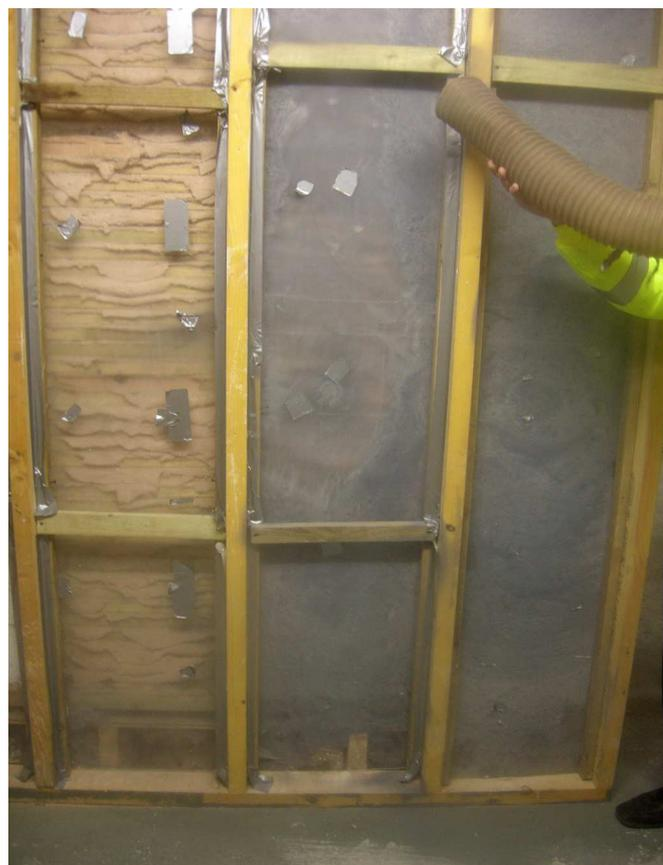
Aerogel hecho de fibra de poliéster, a la que se aferran partículas de aerogel, para combinar rendimiento térmico, permeabilidad al vapor, higroscopicidad y resistencia mecánica ( $\lambda = 0,255 \text{ W/mK}$  con densidad de  $70 \text{ kg/m}^3$ ) | foto Elena Lucchi
