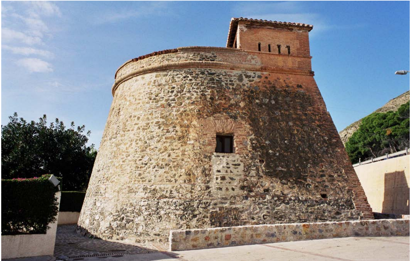
7. Castillo de Baños (Polopos), torre para dos cañones construida en 1767
