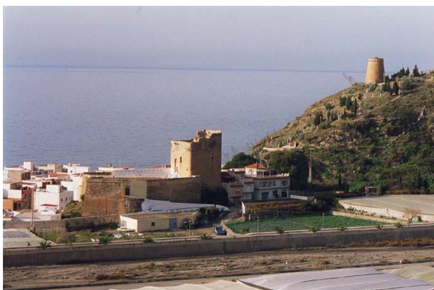
13. Castell de Ferro (Gualchos), fortificación medieval con obras de refuerzo del siglo XVI
