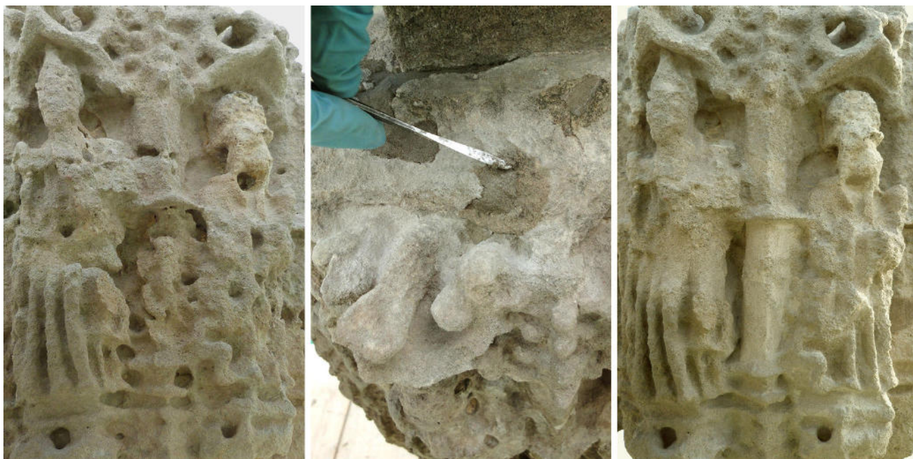
Figura 8. Reintegración: capitel después de la limpieza (izquierda), reintegración de descamaciones y pequeñas pérdidas de volumen (centro) y capitel después de la reintegración. © M. Núria AVECILLA Palau.
