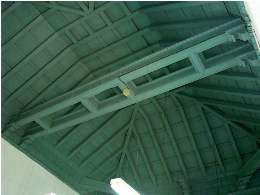
Figura 1. Techos de armadura completamente elaborados con madera. Fotografía: Alina Cuza.
