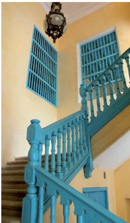
Figura 2. Escalera principal con barandas de gruesos balaustres torneados. Fotografía: Raquel Carreras.
