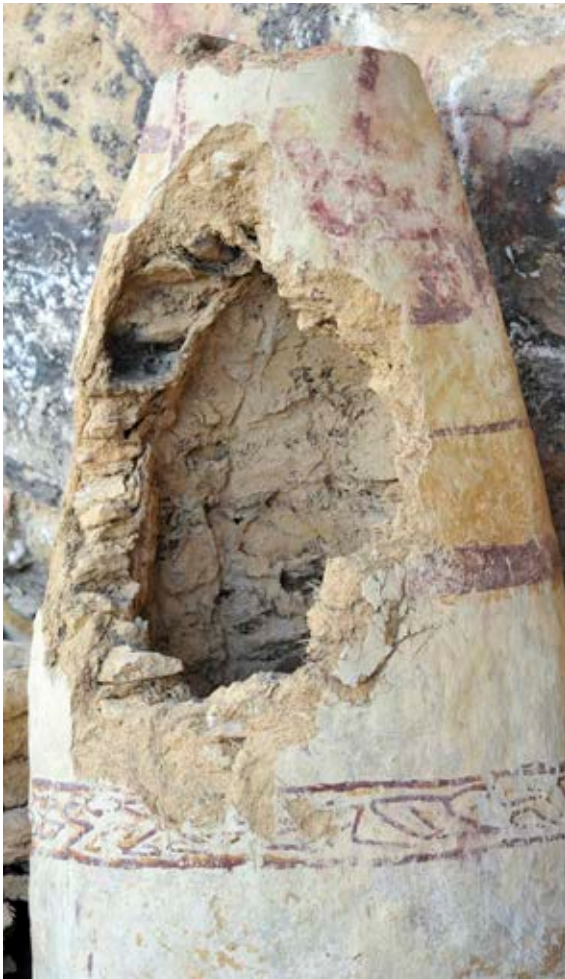
Figura 12. Gracias a su rotura se ve la composición del material utilizado: piedras y barro mezclado con tela. Fotografía: © Ángela Brachetti-Tschohl.
