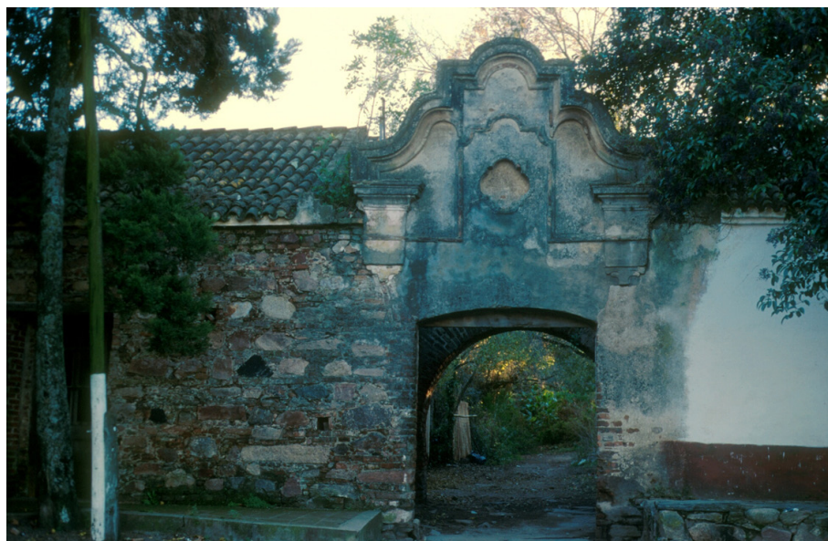
Figura 16. Ingreso al zaguán de las viviendas colectivas de Santa Catalina.
