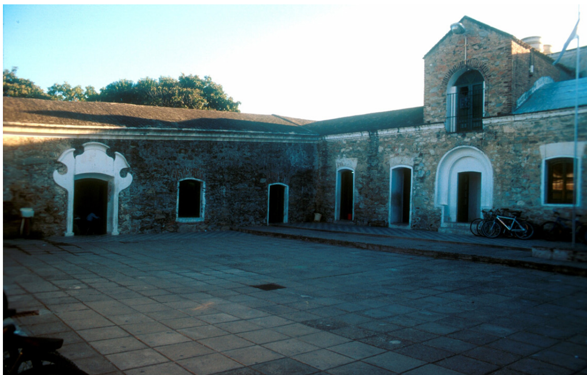
Figura 20. Vista actual del patio del obraje.
