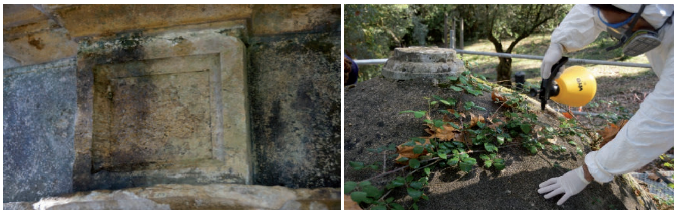
Figura 6.- Limpeza mecânica, por escovagem, de biofilme negro, após primeira aplicação de biocida (à esquerda); Aplicação de herbicida (à direita).
