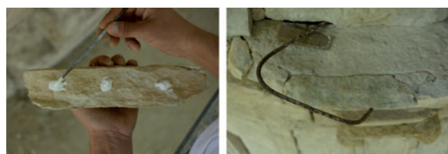
Figura 12.- Fixação de fragmentos.
