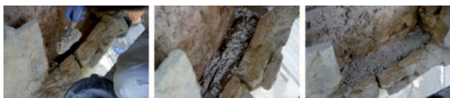
Figura 10.- Preenchimento do sistema de escoamento de águas pluviais, já descaracterizado por intervenções anteriores..
