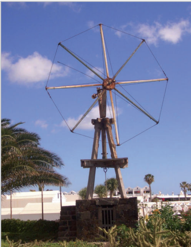
Figura 4.- Aeromotor salinero canario de rotor de aspas de velas. Costa Teguisse. Lanzarote Fotografía: Víctor M, Cabrera García
