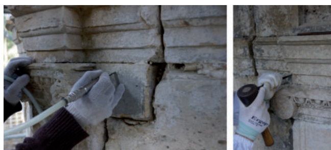
Figura 9.- Remoção de argamassas do tipo cimentícias.
