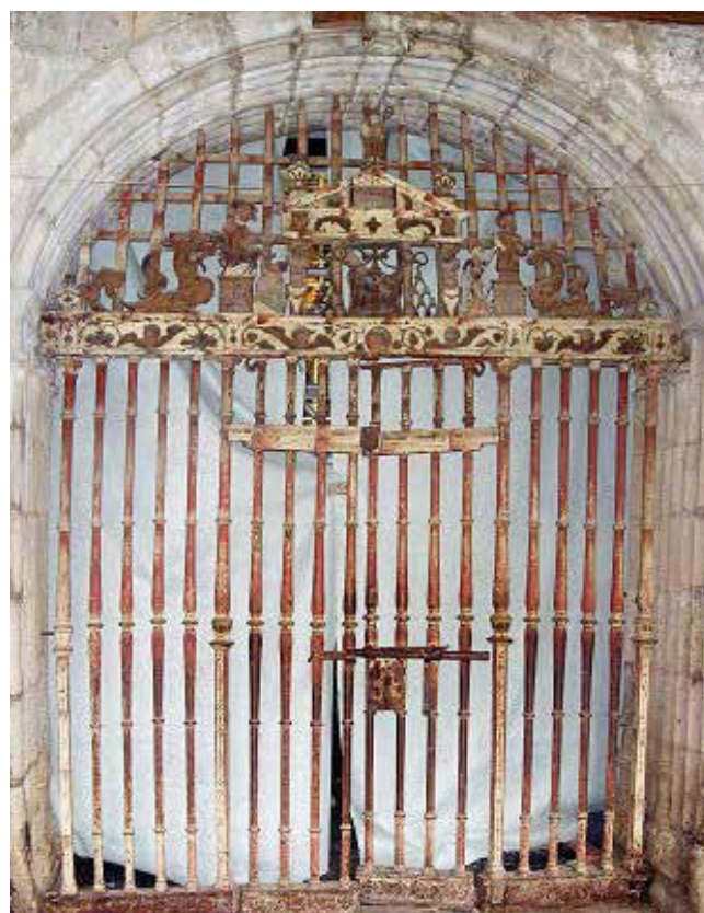
Figura 1.- Aspeto geral da grade antes da intervenção
