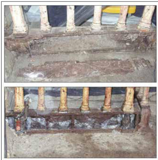
Figura 4.- Remoção da placa do friso inferior, tratamento e reconstituição dessa área
