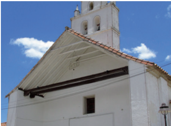
Figura 31. Cubierta de la iglesia de Oicatá-Boyacá. Foto: A. Chica S., 2009.
