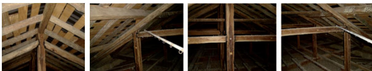
Figura 24. Estado actual de la estructura de cubierta de la iglesia de Turmequé-Boyacá. Foto: A. Chica S., 2009.
