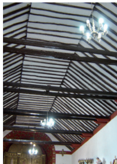
Figura 23. Cubierta en par y nudillo de la iglesia de Chivatá. Foto: A. Chica S., 2009.
