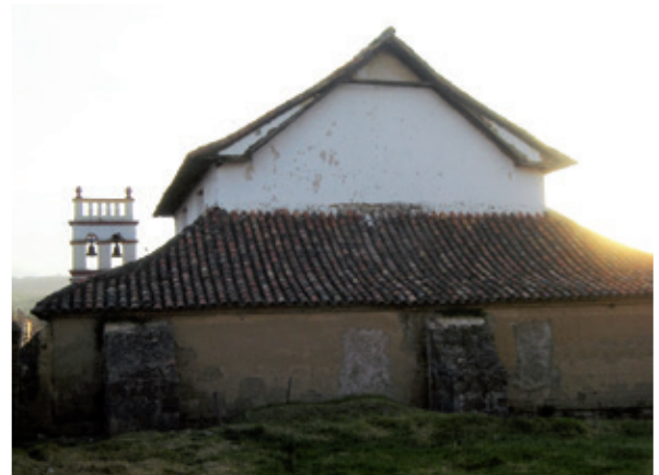
Figura 32. Cubierta de la iglesia de Tota-Boyacá. Foto: A. Chica S., 2011.
